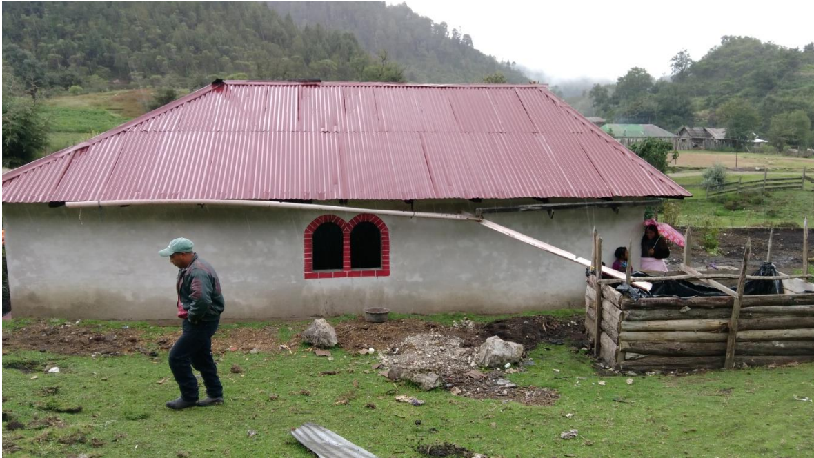
Canales de techo de vivienda utilizados para llenar tanque o toma de agua. Fotografía: Margarita Ramírez Vargas
