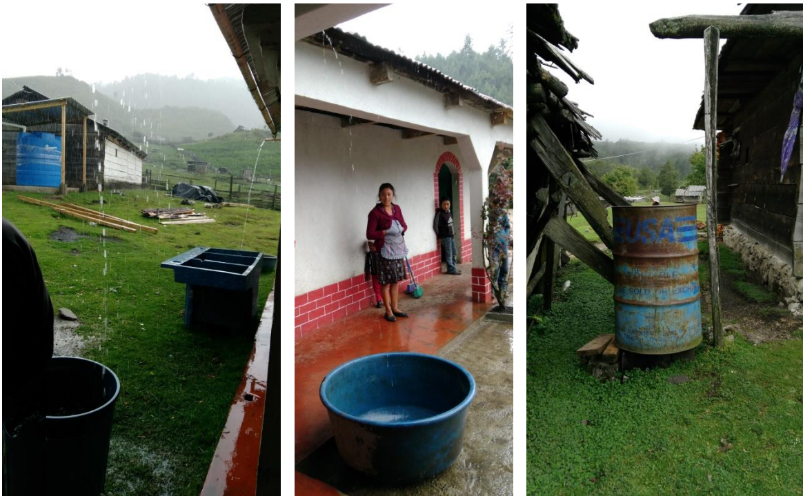
Diferentes formas de recolectar agua de lluvia: recipientes plásticos, pila, toneles metálicos
